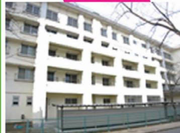
場所打コンクリートアウトフレーム補強建物
