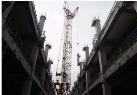
3階柱 立て込み
