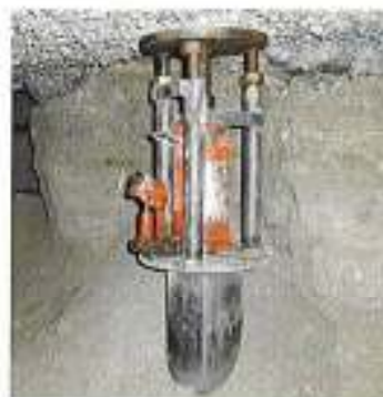
ジャッキにより打ち込まれた鋼管杭
