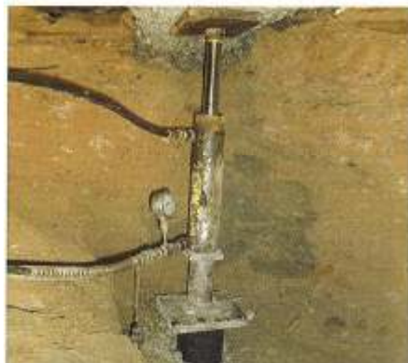
鋼管建て込み(家の荷重を反力として鋼管杭を建て込む)
