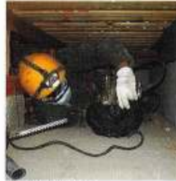
床下での注入作業
