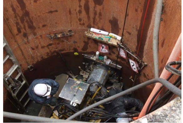
推進機による集排水管理設工事(磯辺)
