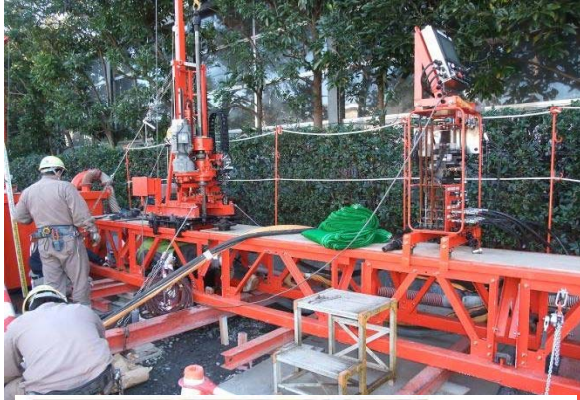
宅地内改良体施工機械(舞浜)
