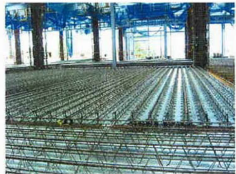
約12mの長尺デッキと敷き込み例
