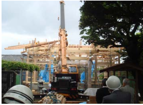
建て方中の妙正寺本堂
