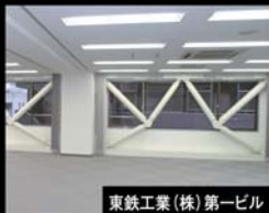
東鉄工業(株)第一ビル
